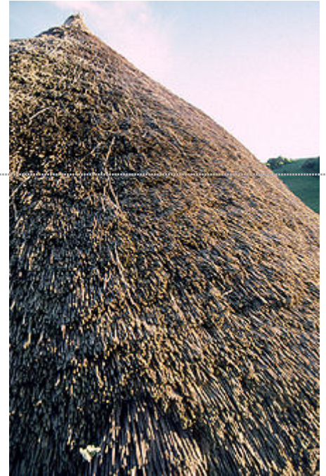
Reconstitution d'un toit de chaume dans le Hampshire , une technique répandue à l'âge du fer.
