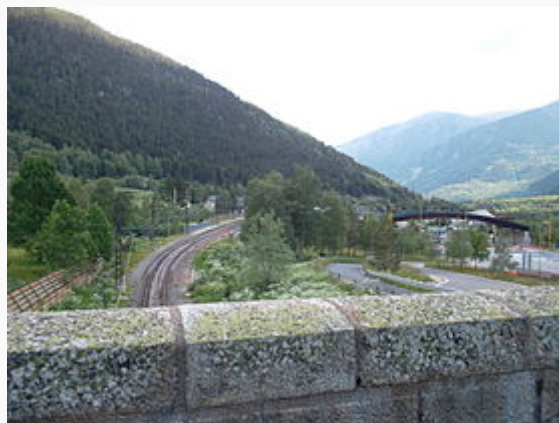
La sortie sud du tunnel
