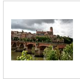
Pont à Albi (env. 1035) dans le Tarn
