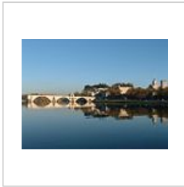
Pont Saint-Bénézet (1177–1188) Avignon dans le Vaucluse
