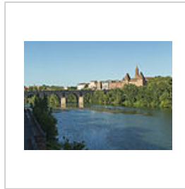
Pont à Montauban (env. 1336) en Tarn-et- Garonne
