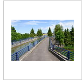
Pont canal sur la Largue à Dannemarie .
