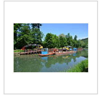
Travaux de réfection entre Aveney et Thoraise (Doubs).
