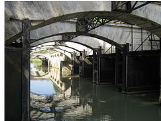
Les ouvrages du Libron
