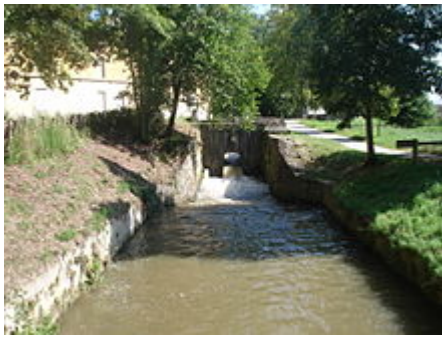
Arrivée de la rigole de la plaine dans le bassin de Naurouze, source principale d'eau du canal du Midi.
