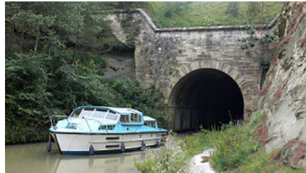
Le tunnel de Malpas
