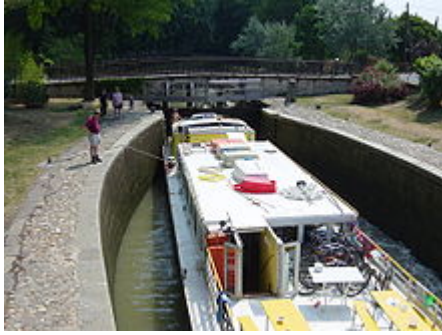
Péniche Le Tourville dans le sas de l'écluse de l'Aiguille, une embarcation actuelle.
