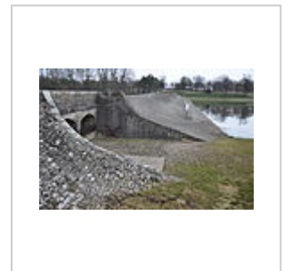
Déversoir et digue de Goule.
