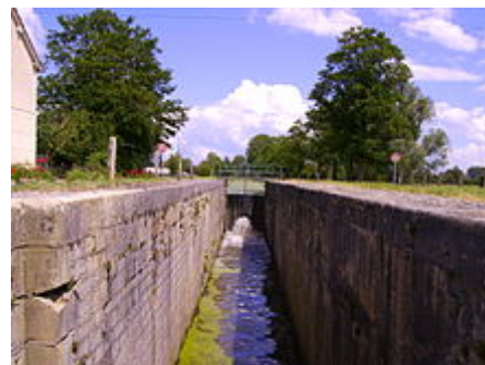
Écluse de Clairins, à Saint Amand Montrond
