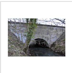
Pont-canal du Rhimbé, sur le Sagonin.
