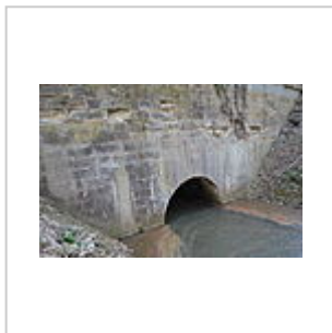
Pont-canal du Rhimbé, sur le vieux Sagonin.
