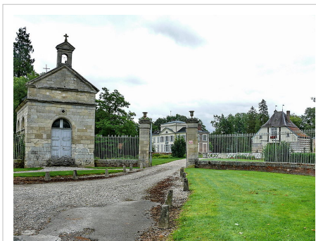
Entrée du Château de Luzières à Conty. La chapelle est à gauche du cliché
