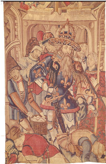
Tapisserie représentant Charlemagne visitant le chantier du palais d'Aix-la-Chapelle (Musée des beaux-arts de Dijon).
