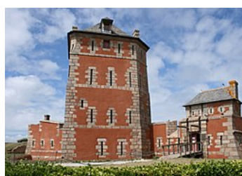
La tour Vauban construite à Camaret pour protéger la rade de Brest
