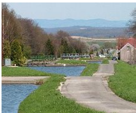
Échelle d'écluse au seuil de Valdieu-Lutran.
